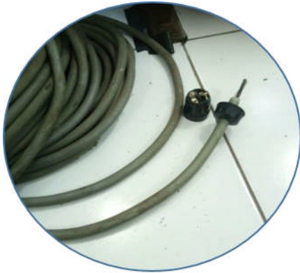
Gambar. 2. pemasangan sistem kelistrikan
