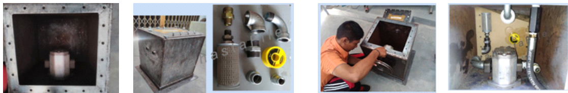
Gambar 9. Pembuatan konstruksi tangki minyak sekaligus sebagai rumah pompa hidrolik sumber tenaga, fondasi tangki dan sambungan kopel motor diesel penggerak
