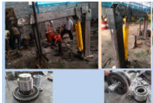
Gambar 19. Pembuatan konstruksi tiang utama dan fondasi sistem gigi pemutar tiang
