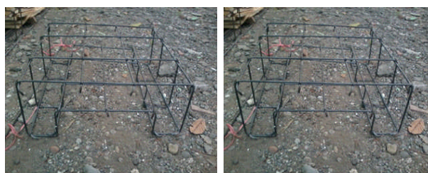
Gambar 4. Model rangka besi yang sudah dibuat.
