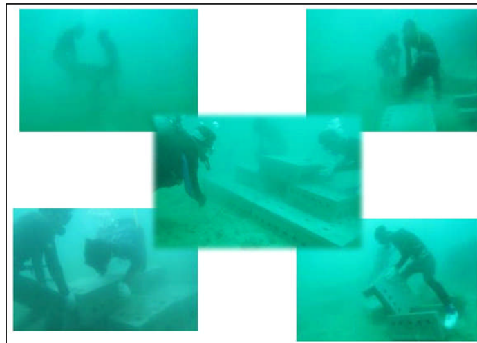
Gambar 12. Pemasangan modul terumbu buatan di bawah air dengan diawasi oleh seorang peneliti.
