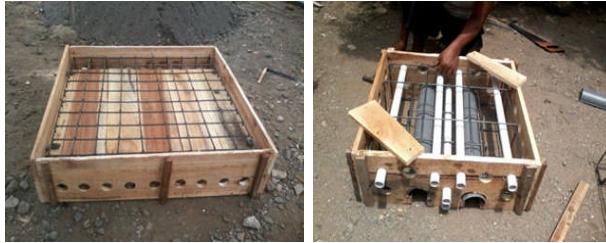
Gambar 6. Rangka besi dan pipa pvc yang sudah dimasukkan kedalam cetakan.
