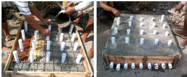
Gambar 7. Coran beton yang sudah dimasukkan kedalam cetakan.
