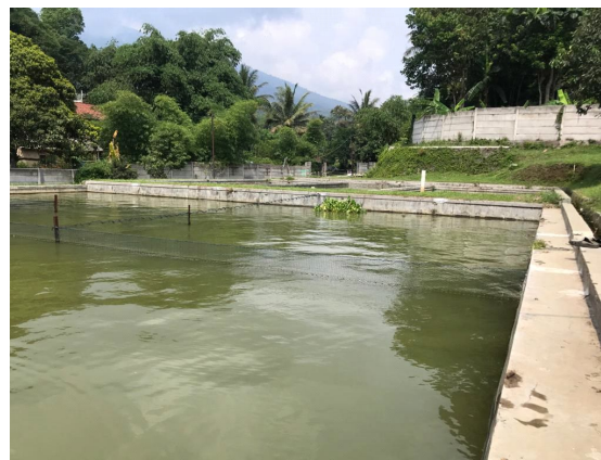
Gambar 2. Kolam semi-beton tempat pemeliharaan ikan tapah.
