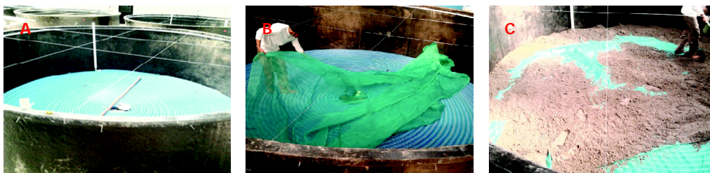
Gambar 1. Rangkaian selang spiral dasar bak sistem resirkulasi terdiri atas selang spiral (A), waring hijau (B), dan pasir (C)
