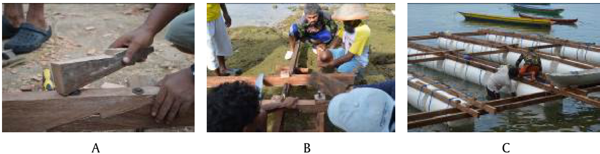
Gambar 2. Penyambungan balok kayu (A), perakitan rakit (B), pemasangan pelampung (C)
