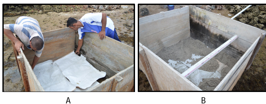
Gambar 2. Pembuatan pencetak jangkar (A); pembuatan jangkar (B).
