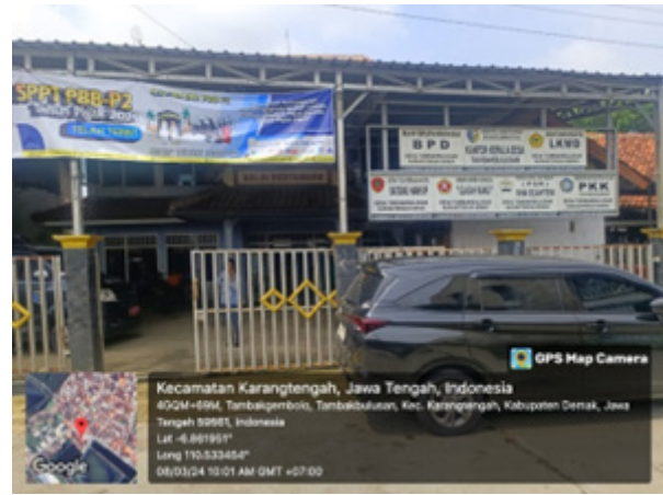
Gambar 9. Balai pertemuan di lokasi penelitian tidak tergenang.
