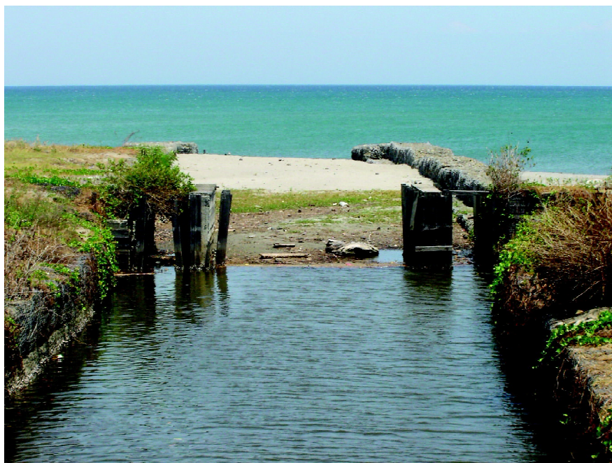
Gambar 3. Pembuatan drainase tambak di Kabupaten Pinrang yang tidak mempertimbangkan secara matang dinamika hidro-oseanografi (Foto: Akhmad Mustafa, 2006)
