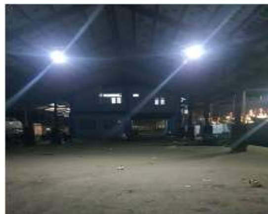
Sesudah Pemasangan Panel Surya
