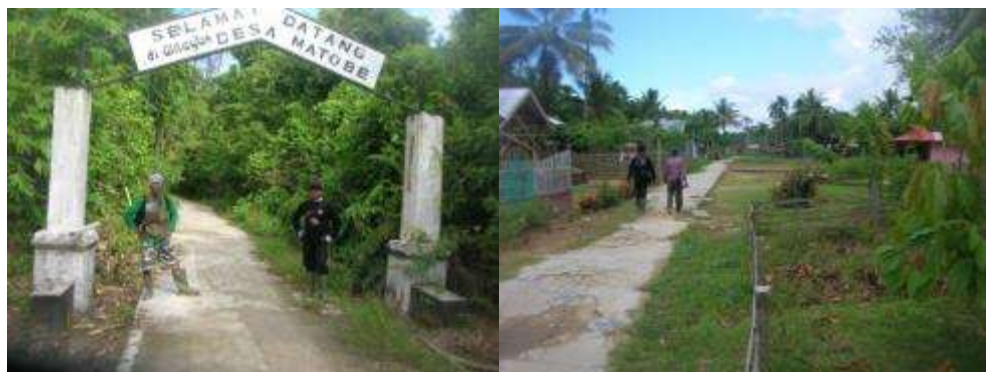
Gambar 6-10. Kondisi Jalur Evakuasi (Gerbang Desa Matobe) di Dusun Matobe Tunang dan Dusun Polaga, Desa Matobe.
