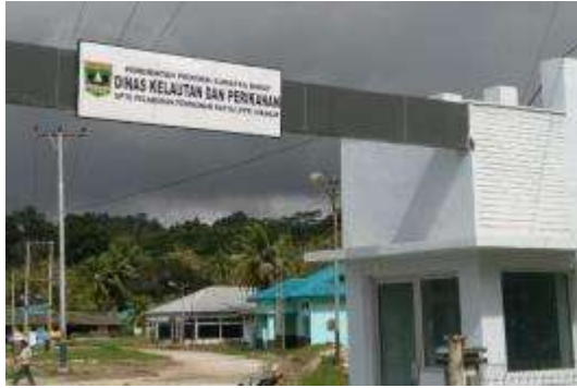
Pintu gerbang PPP Sikakap
