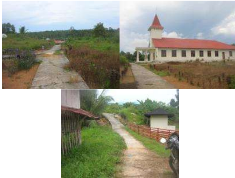
Gambar 6-14. Kondisi Jalur Evakuasi dan Shelter Tsunami di Dusun Silabu Barat
