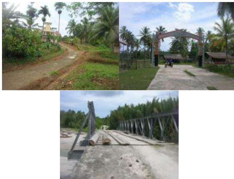
Gambar 6-7. Kondisi Jalur Evakuasi dan Shelter Tsunami di Dusun Pasapat, Desa Saumanganya.
