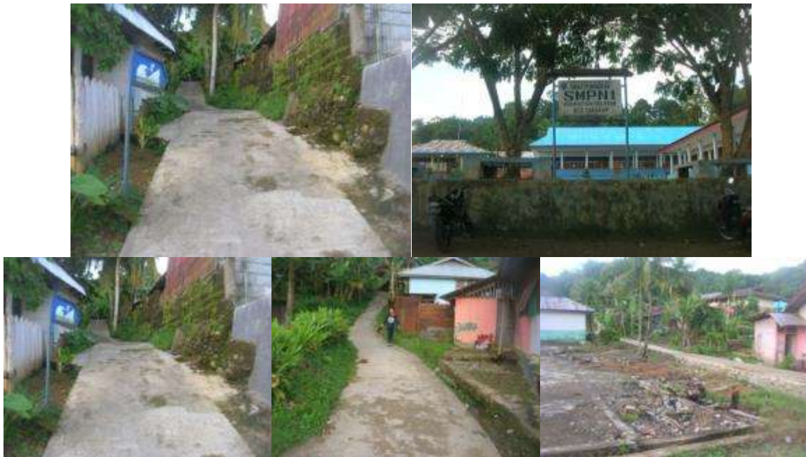
Gambar 6-20. Kondisi jalur evakuasi dan shelter Tsunami di Dusun Sikakap Tengah dan SMPN1 Sikakap, Dusun Sibaibai, Desa Sikakap.
