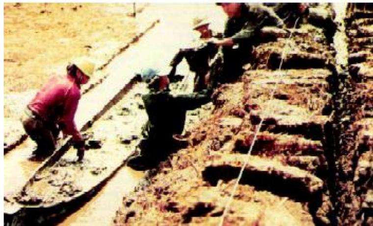
Gambar 4. 7 Konstruksi pematang tambak tanah gambut dengan pengisian tanah liat pada bagian tengah pematang untuk mengurangi kebocoran (Mustafa, 2008).
