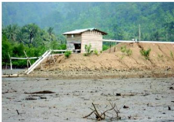
Gambar 4. 5 Saluran tipe tertutup yaitu pipa yang menyalurkan air yang dipompa dari laut yang dasar perairannya berlumpur (Mustafa, 2008).
