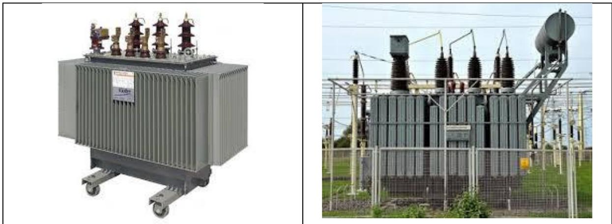
**Gambar 6.11 Transformator Tenaga Listrik.**
