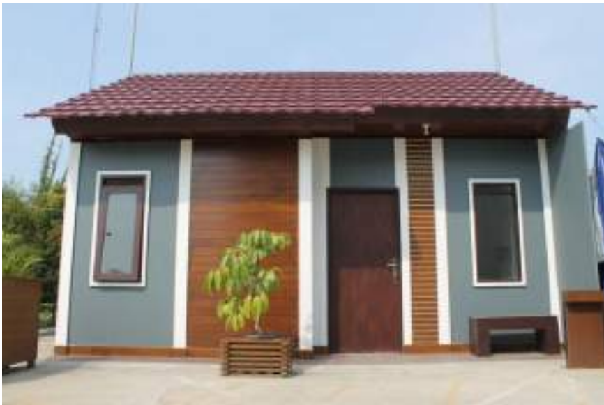
Gambar 58. Rumah Conwood yang konstruksinya terdiri dari campuran semen dan serat fiber didesain bukan hanya tahan gempa, tapi juga anti rayap dan tahan api.
