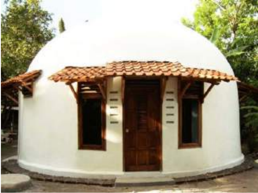
Gambar 53. Rumah Dome yang didesain untuk rumah tahan gempa
