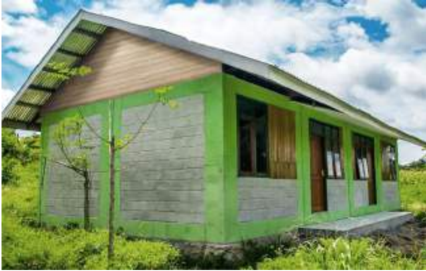
Gambar 57. Rumah unggul sistem panel (Ruspin) yang didesain oleh Balitbang Kementerian PUPR memiliki kemampuan tahan gempa
