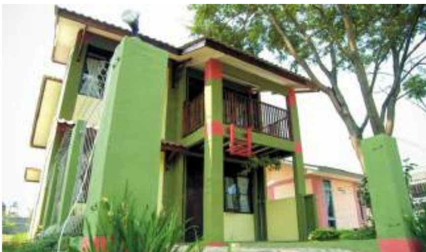
Gambar 55. Rumah instan sederhana sehat (Risha) yang merupakan konstruksi bangunan rumah dengan beton bongkar pasang
