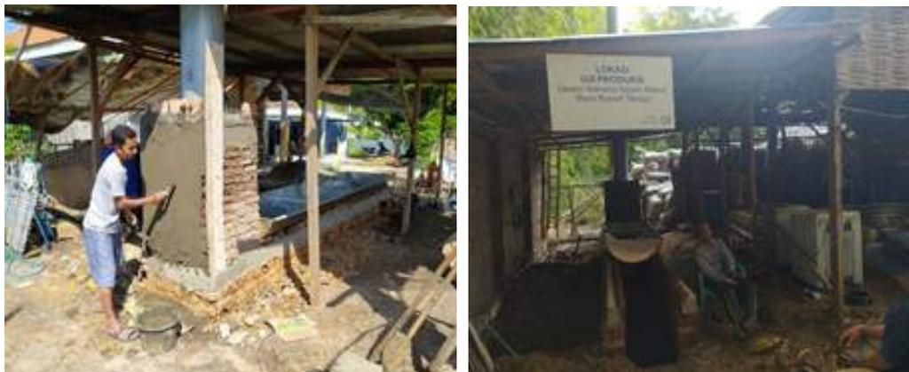
**Gambar 32.** Proses pemasangan dan pembuatan tungku produksi garam rekristal di halaman rumah Bapak Mulyadi (kiri). Diskusi, pembuatan/install alat dan rencana uji produksi skala rumah tangga di halaman rumah Bapak Akhmadi (kanan).
