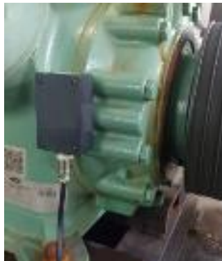
Gambar 7 Posisi Sensor Mendeteksi Getaran, Temperatur Dan Noise Pada Mesin Kompresor.
