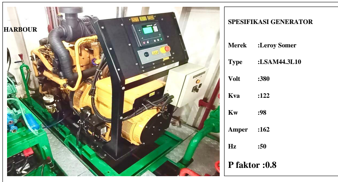
Gambar 2 Spesifikasi Generator Harbour / Cadangan KP Hiu Macan Tutul 01 (sumber gambar : KP HIU Macan Tutul 01)
